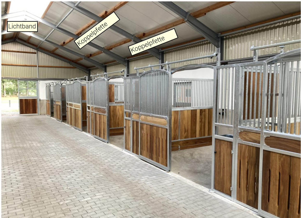
Bild 1 Holzkoppelfetten nach 4.2 und Lichtband nach 4.1 nicht mehr zulässig (Quelle: https://schlichtmann-hallenbau.de/portfolio/pferdestall-epe )
